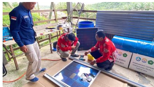
Gambar 3. tim memasang Panel Surya dan Panel PV
